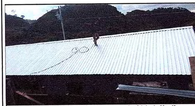
Foto 5: Cambio total del cubierta de lamina en el módulo de 3° y 4° primaria.
