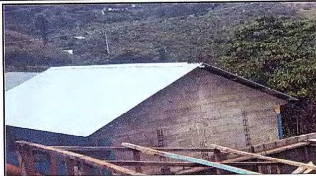
Foto 2: Cubierta total de lamina troquelada, en el aula de sexto primaria.
