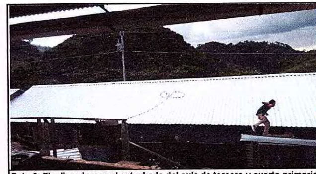
Foto 6: Finalizando con el entechado del aula de tercero y cuarto primaria.
