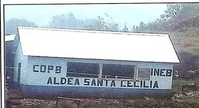
Foto 3: Lamina troquelada en salón de prepa 3, cambiado en su totalidad.
