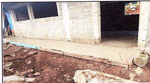
Foto 4: Aulas de 3° y 4° primaria ya con el corredor nuevo.
