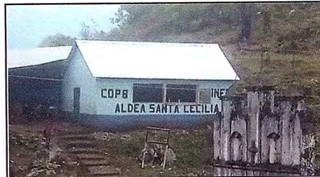
Foto 4: Así quedó el trabajo final de todo el entechado del aula de preprimaria 3.
