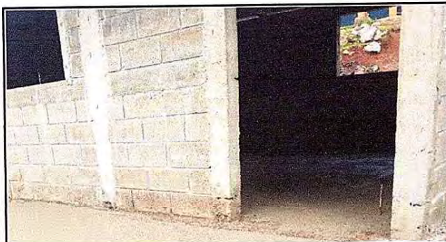
Foto 3: Parte interna del salón ya con el nuevo piso terminado por completo.
