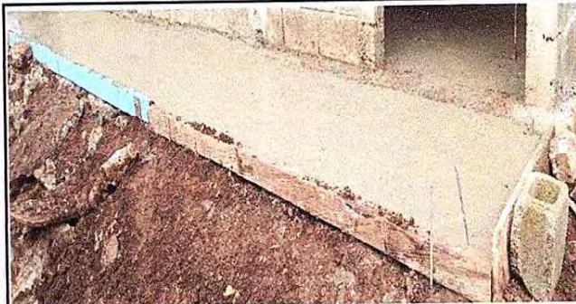
Foto 2: Parte del corredor terminado en su totalidad, con el nuevo entortado.
