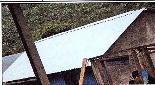
Foto1: Se puede observar entechado final en el aula de sexgto primaria.
